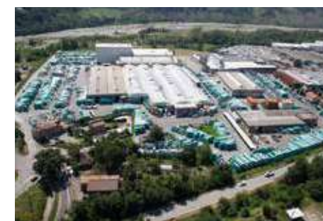
Cotto Petrus Uffici, Stabilimento Produttivo, Atomizzatore e Magazzino (Offices, Production Plant, Spray dryer and Warehouse)
