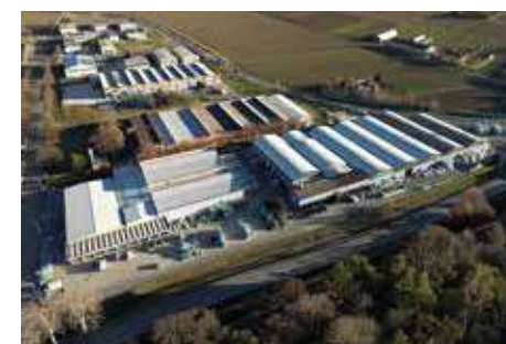
Dado Ceramica Uffici e Stabilimento Produttivo (Offices and Production Plant)
